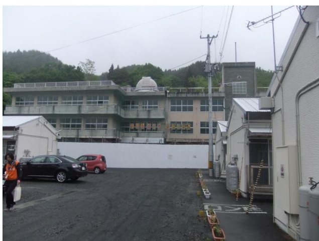
取り壊しを待つ大槌安渡小学校
