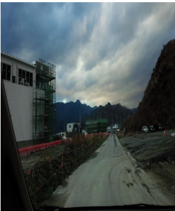
がれきが撤去され嵩上げが始まる・・・
