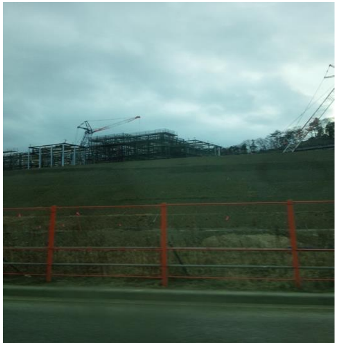
嵩上げが完了した地区に大型施設を建設中（3/14）
